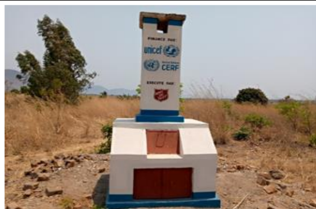
Incinérateur fini et opérationnel
