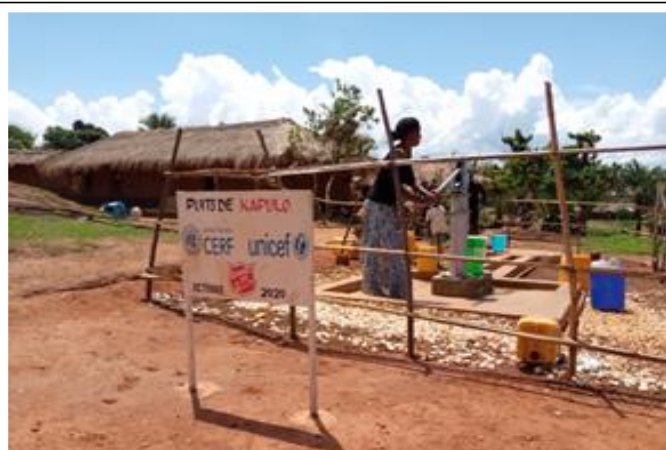
Puits fini et opérationnel
